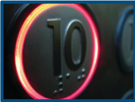
Los botones de emergencia y parada deben estar situados en la parte inferior del panel de control. Los botones del panel de control, así como los de llamada en cada nivel deben estar demarcados con el sistema Braille. Deben tener pasamanos en los cerramientos fijos. Dispositivos auditivos y luminosos, que orienten a las personas sobre la proximidad del piso a arribar o sobre el cual se encuentran.
